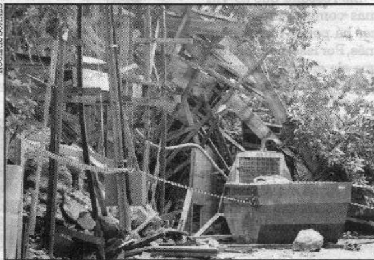
Após um deslizamento, uma obra desmoronou, ferindo 4 operários
